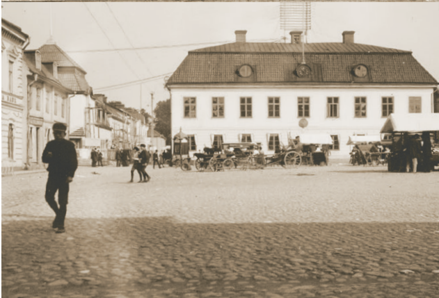
Rådhuset, det antagna ritningsförslaget och foto från 1920-talet innan det nya klocktornet byggdes 1927 (Sala kommuns arkiv).
